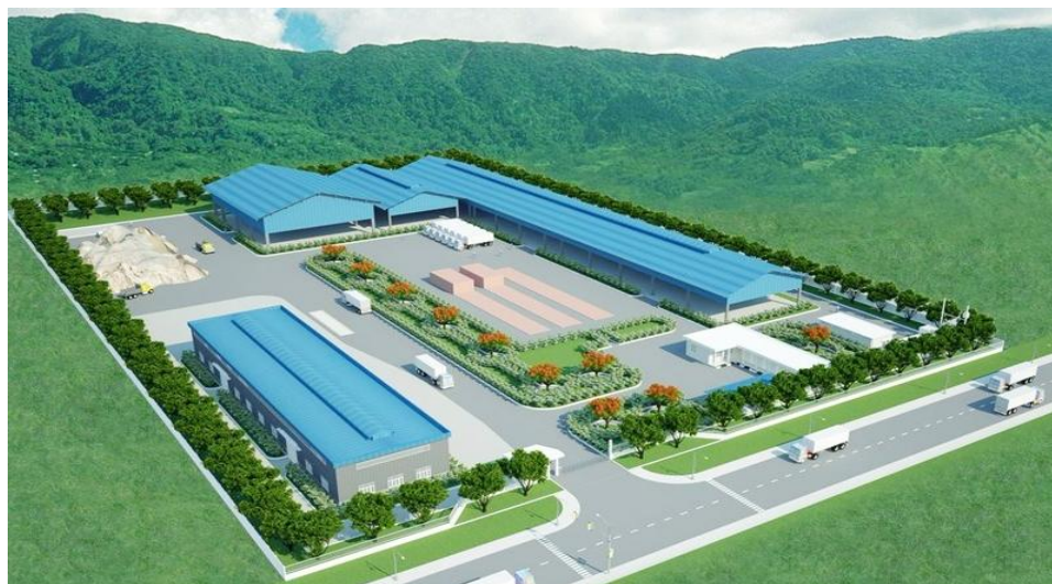
Hình ảnh: Dự án Nhà máy sản xuất gạch Tuynel
